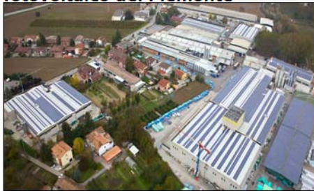
Panoramica aerea dell'impianto sui tetti della Mondo
